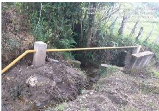
Se instala una guaya para templete y soportar la tubería, y no dejar que la tubería presente inclinaciones o serpenteo alguno.
