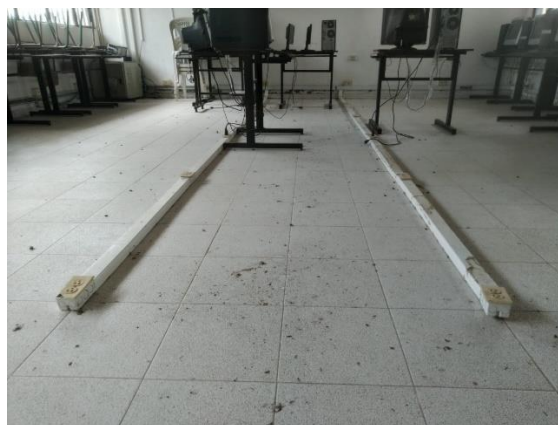
Fotografía 3 – 5: Nótese la disponibilidad de energía mediante conexión domiciliaria y medidor, interruptores y luminaria de energía en el aula de la Institución Miralindo.
